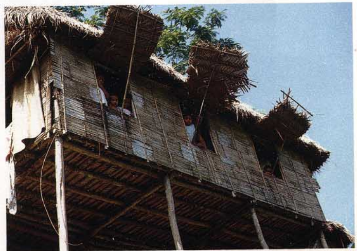
山の斜面に建てられたセノイ族のバンブーハウス。子どもたちが窓から顔をのぞかせている。この部屋は地上4メートルくらいのところにあり、竹の床が抜けたらどうしようかとびくびくしていた。風とおしは最高
